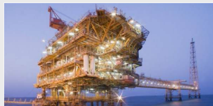
پروژه سکوی فاز ۱۱ پارس جنوبی
